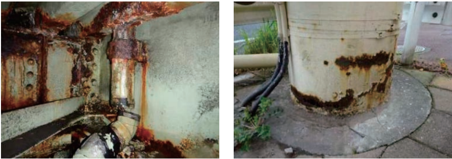
横断歩道橋老朽化状況例（国土交通省「横断歩道橋個別施設計画」より）
