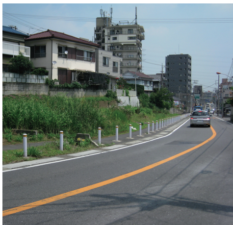
中原街道の拡幅工事中
